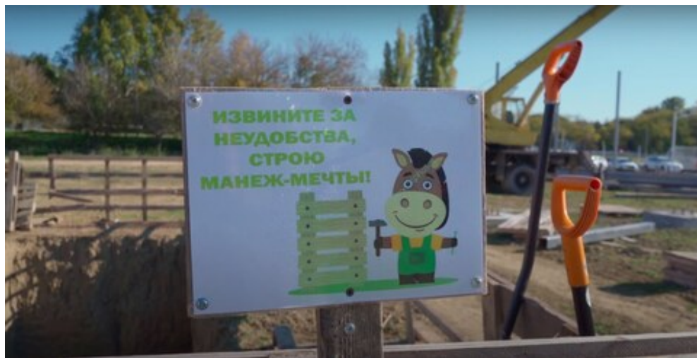
Территория стройки огорожена для безопасности посетителей
