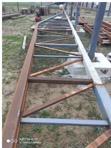
Установлены опорные столбы, сварены фермы крыши (2)
