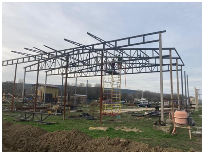
В процессе строительства
