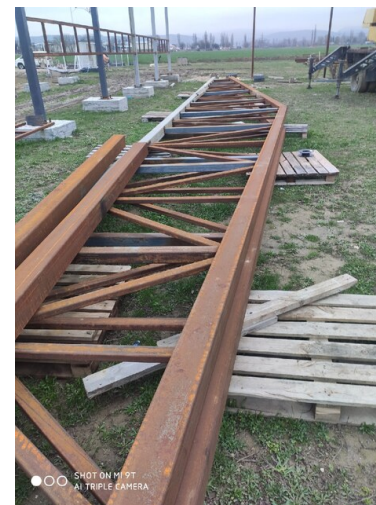
Установлены опорные столбы, сварены фермы крыши (1)
