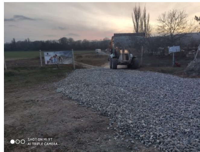
Ход работ по отсыпке дороги и парковки
