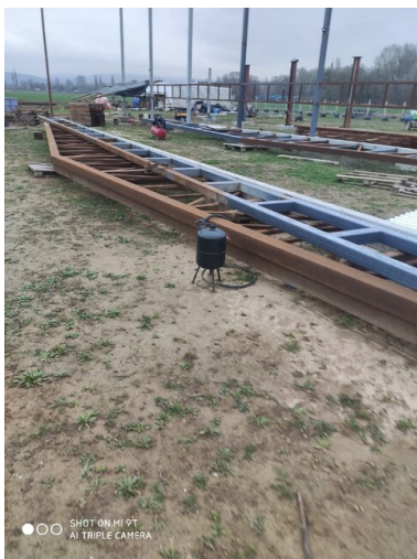
Установлены опорные столбы, сварены фермы крыши (3)
